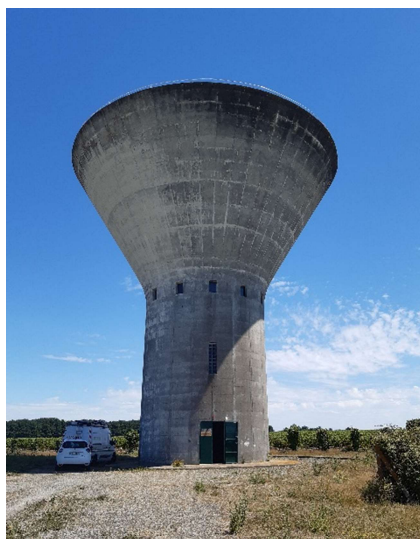
Château d'eau de la Jubinerie
