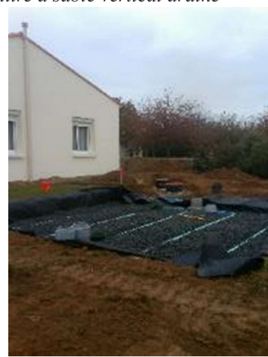
Filtre à sable vertical drainé
