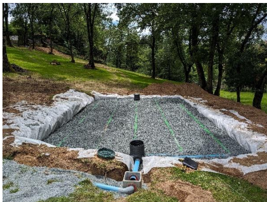
Filtre à sable vertical
