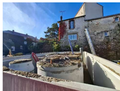
Remblayage autour des cuves réhaussées au poste de relevage Le Pont à Monnières.
