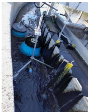
Nettoyeur de goulotte de clarificateur
