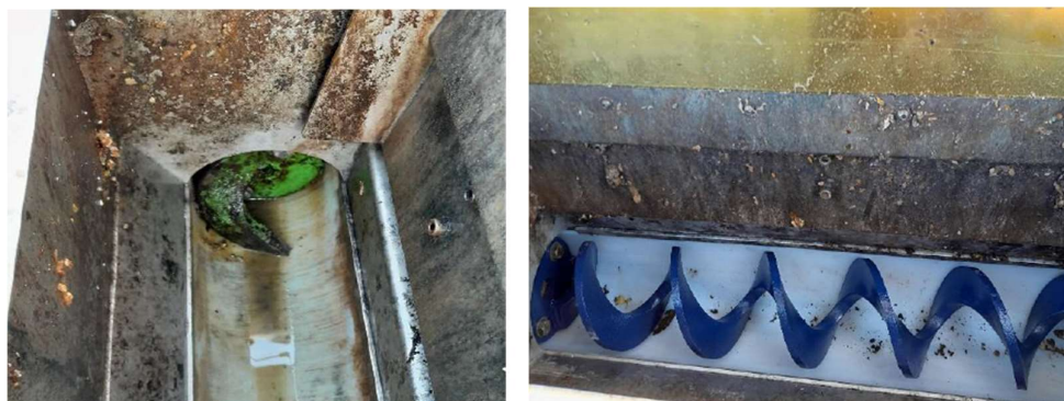
Photos avant et après le renouvellement de la vis de compactage des déchets.
