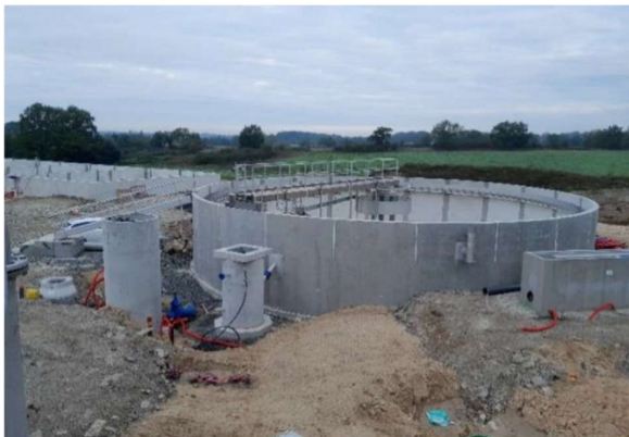
Construction de la nouvelle station à Boussay
