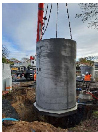
Livraison de la cuve du poste Caillerie à Clisson.
