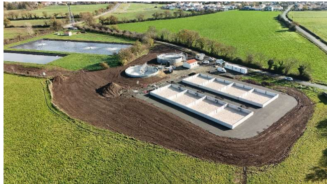
Vue aérienne de la nouvelle station en construction et des lagunes de l'ancienne station en arrière-plan.
