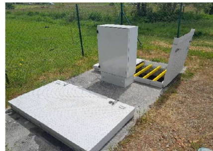
Trappes et barres antichute au PR route de Sarroux
