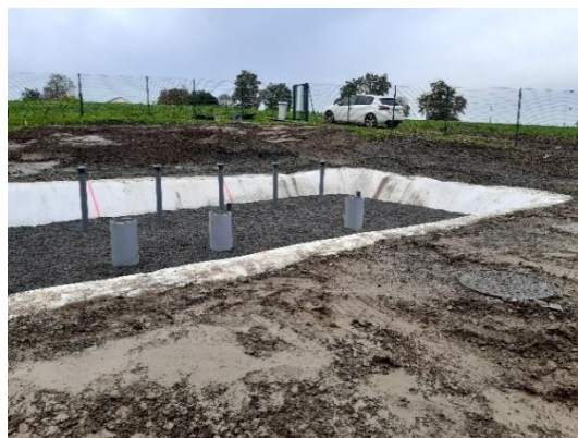
Réhabilitation de la STEP du Plessis Renard
