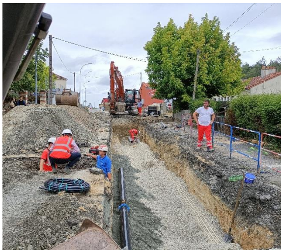
Travaux Fief des pommiers - 2023
