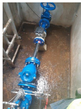
Compteur d'achat d'eau sur le réseau de transport avec débitmètre à Gorges
