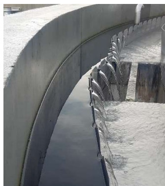
Mise en eau du clarificateur sur la nouvelle station d'épuration de Remouillé
