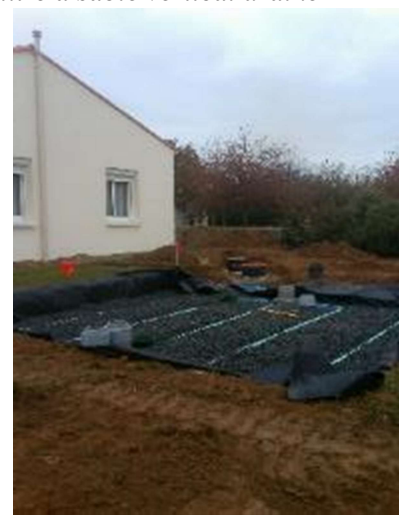
Filtre à sable vertical drainé
