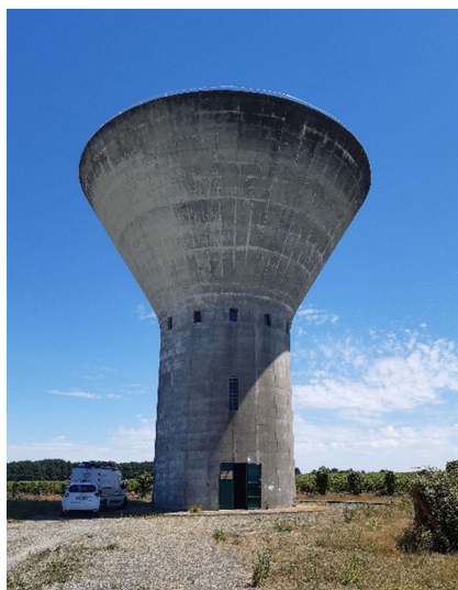
Château d'eau de la Jubinerie
