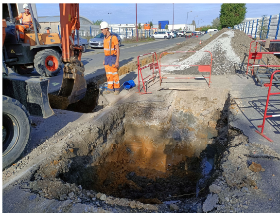
Extension rue des ajoncs
